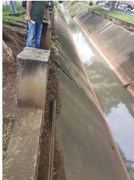
Afectaciones a las losas y paredes del canal de aguas lluvias de la Autopista Sur Oriental por prolongación radicular de individuo de especie Ficus Benjamina – se observa la fijación de estructuras en concreto sobre las franjas de los canales ajenos a la estructura principal.
