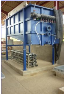
Instalación del DAF en Caseta de la PTL
