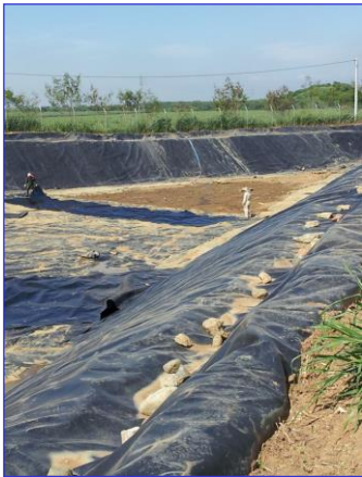
Instalación de Geomembrana para las lagunas de Evaporación y Cristalización
