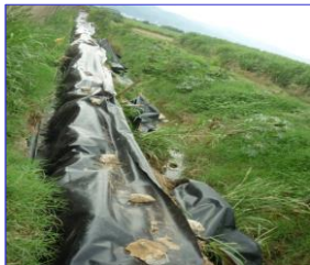
Instalación de Geomembrana de Impermeabilización de la Zanja
