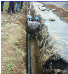
Instalación de Tubería Perforada para Recolección de Lixiviados
