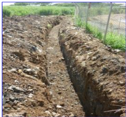
Excavación Zanja de Recolección de Lixiviados
