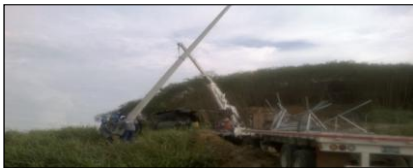
Colocación de Postes para Conducción de Energía desde la Red Local de Emcali
