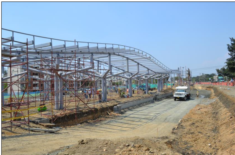
Figura 45. Instalación estructura metálica (columnas apoyo de cubierta) zona de plataforma principal de la terminal
