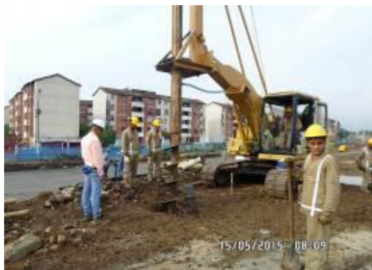
Figura 38. Excavación de pilotes para cimentación de la plataforma principal de la estación.
