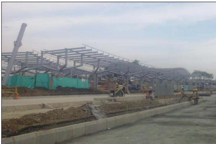
Figura 41. Instalación estructura metálica (columnas apoyo de cubierta) zona de plataforma principal de la estación.
