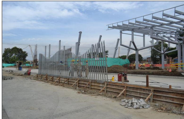
Figura 44. Instalación cerramiento de la Terminal costado oriental
