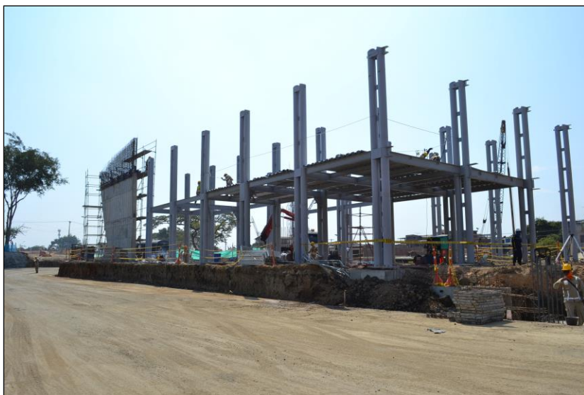
Figura 42. Instalación estructura metálica (columnas apoyo y Steel deck entrepiso)) zona edificio Portal norte de la terminal.
