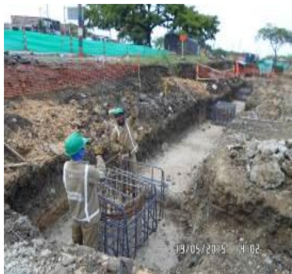
Figura 39. Armado acero de refuerzo para construcción de dados y vigas de cimentación en la plataforma principal de la estación
