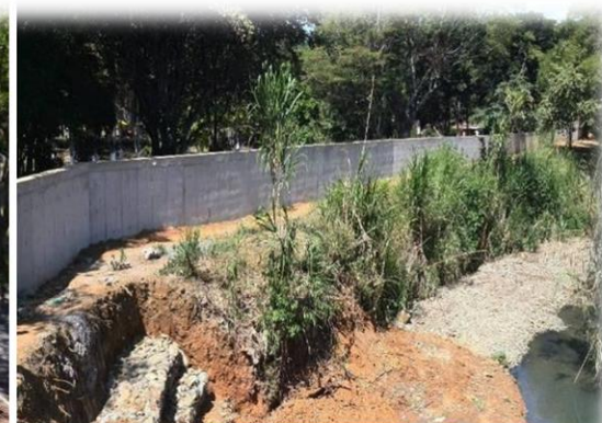
Dique en la parte sur del parque El Ingenio. Muro de contención para control de erosión en Calle 14
