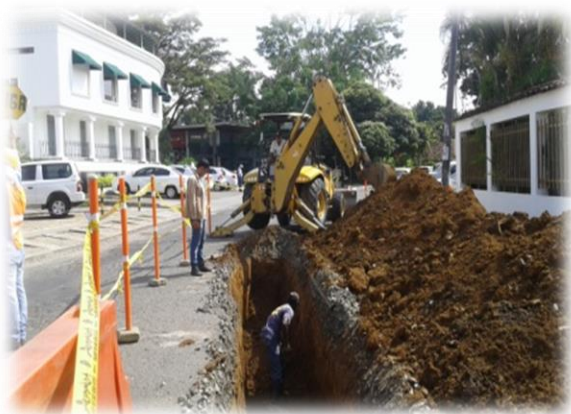
Construcción de interceptores en el río Cali, río Lili y en el río Cañaveralejo
