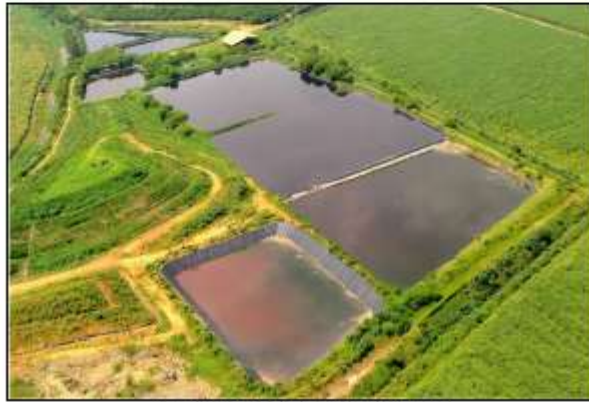
Lagunas de almacenamiento de lixiviados
