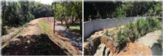
Obra en la parte sur del curso El Anzuelo. Muñe de capacidad para control de erosión en Cali. 14
