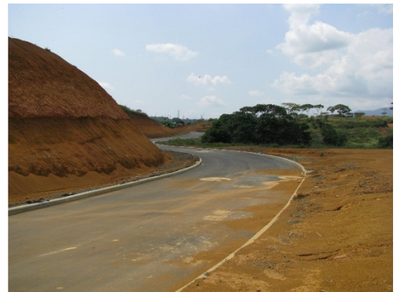
Foto 4. Banqueos y pavimentación
