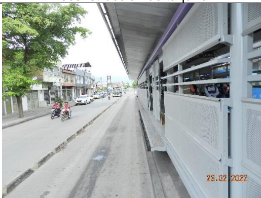
Instalación de láminas metálicas de cerramiento, banda de aproximación
