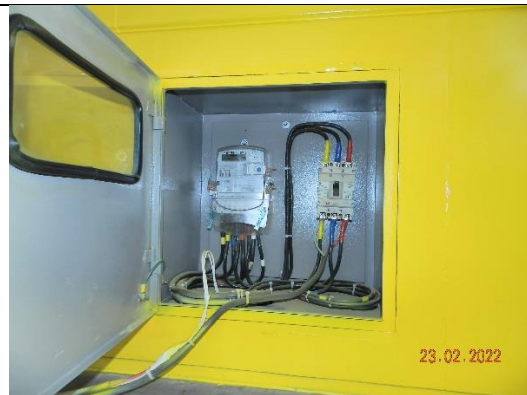
Instalaciones eléctricas, tablero de control
