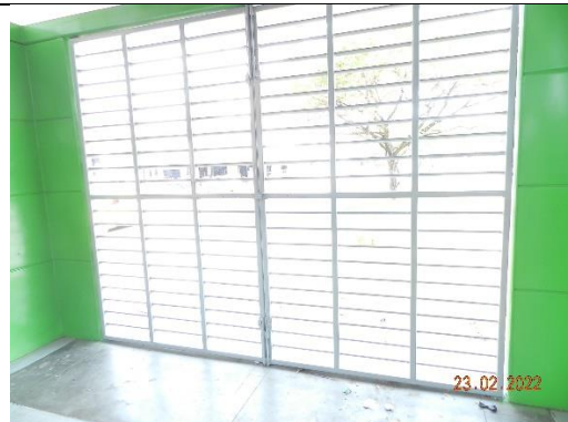
Reconstrucción de puerta posterior en reja metálica
