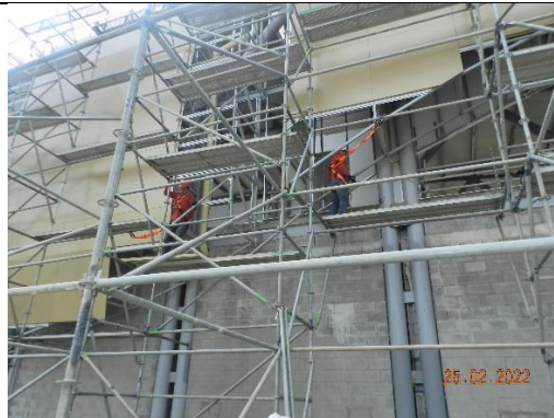
Reconstrucción de fachada en lámina metálica. Utilización de andamios certificados y elementos de protección para trabajos en altura
