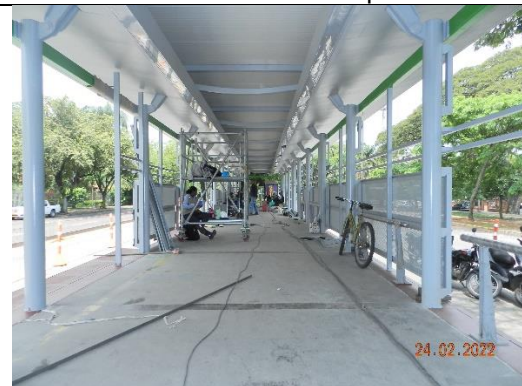
Instalación de láminas metálicas de cerramiento, reparación de cubierta y cielos
