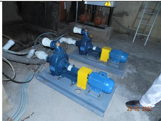
Suministro e instalación de motobombas
