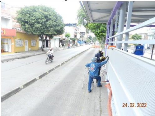
Instalación de láminas metálicas de cerramiento
