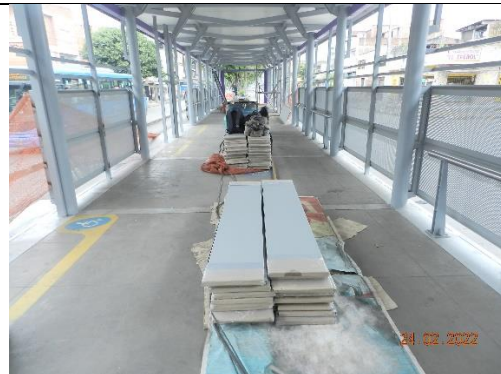
Instalación de láminas metálicas de cerramiento, suministro de láminas metálicas
