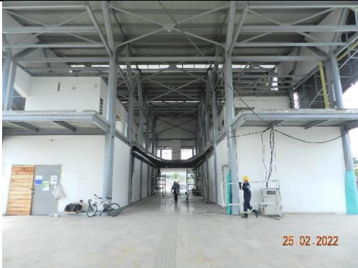
Recuperación reconstrucción de estructura metálica, pintura de muros, portal sur.
