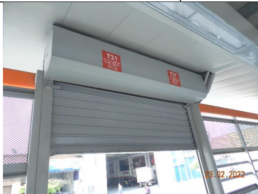
Instalación de puertas metálicas enrollables., señalética
