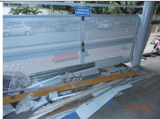
Instalación de láminas metálicas de cerramiento,
