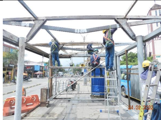
Pintura de estructuras metálicas
