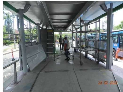
Instalación de láminas metálicas de cerramiento,
