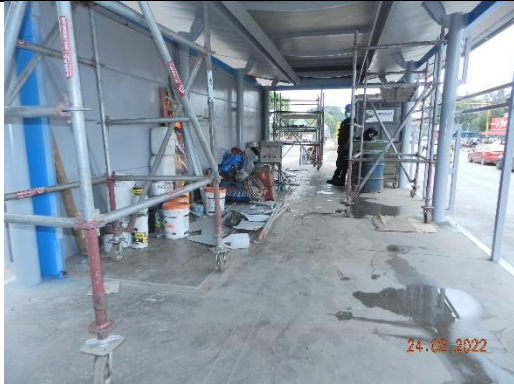
Instalación de láminas metálicas de cerramiento, recuperación de cielos y cubierta metálicas
