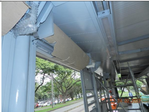
Instalación de puertas metálicas enrollables.,
