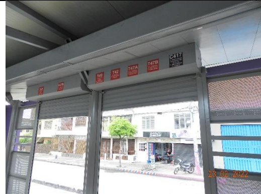
Instalación de puertas metálicas enrollables., señalética
