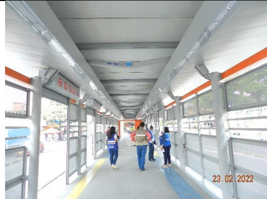
Instalación de láminas metálicas de cerramiento, puertas metálicas enrollables, recuperación de cielos y cubierta metálica
