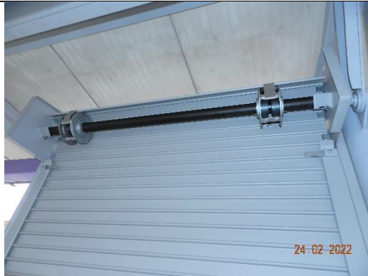
Instalación de puertas metálicas enrollables
