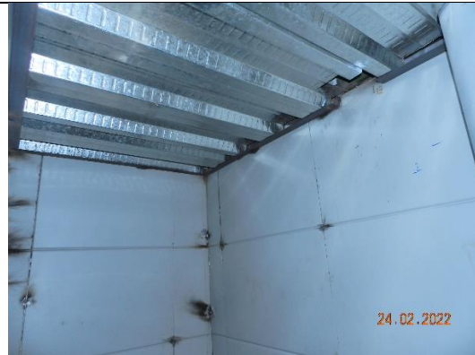
Construcción de cubierta de taquilla, en doble lámina metálica
