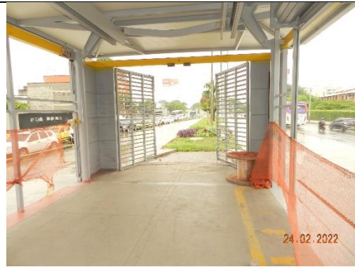
Reconstrucción de puerta posterior en estructura metálica
