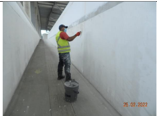
Recuperación de muros de rampa peatonal, estuco y pintura
