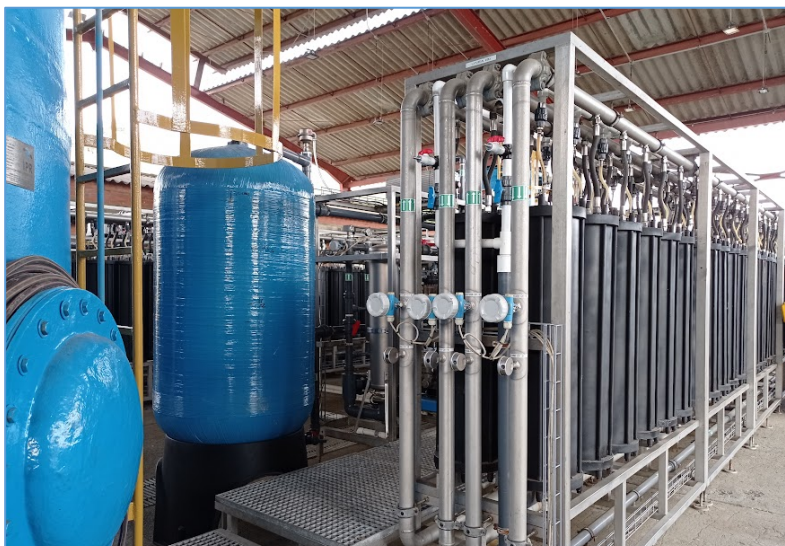
Figura 2. Componentes Primera etapa de tratamiento de filtración por membranas.
